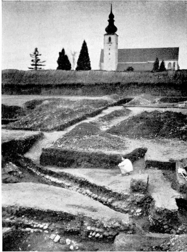
Abb. 3 Heizungsanlage der Basilika auf dem Forum Venale (Fundort des Stadtrechtes)
