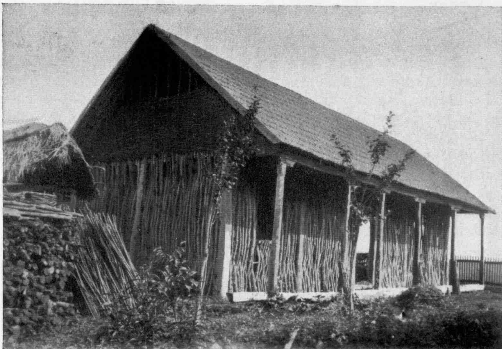
1. Gerippe eines schwäbischen Holzhauses aus Groß-Sufunda (Satmarer Komitat, Rumänien).
